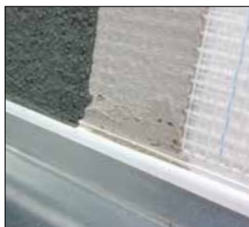
Foto realizace připojovacího profilu HPI - UNI
