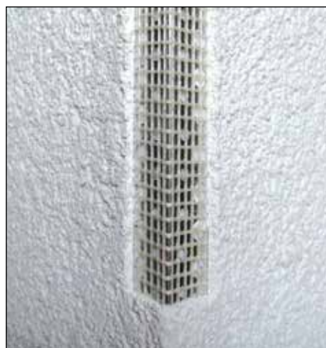
Detail umístění kombi lišty - řez
