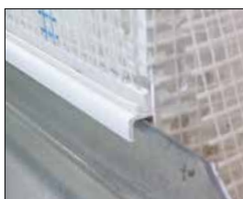
Detail aplikace připojovacího profilu parapetního
